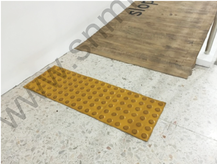
ภาพที่ 31 ตัวอย่างการติดพื้นผิวที่ต่างสัมผัส เพื่อเตือนให้คนตาบอดทราบว่าพื้นสิ้นสุด หรือมีการเปลี่ยนระดับหรือมีทางแยก
